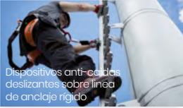
Dispositivos anti-caída deslizantes sobre línea de anclaje fijo
