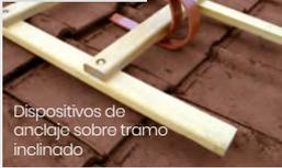
Dispositivos de anclaje sobre tramo inclinado
