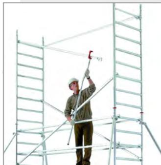
Montaje en seguridad gracias a la percha de montaje
