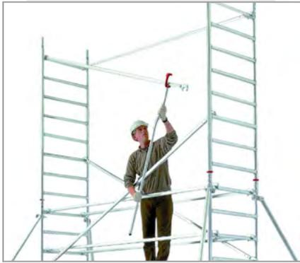
Montaje en seguridad gracias a la percha de montaje
