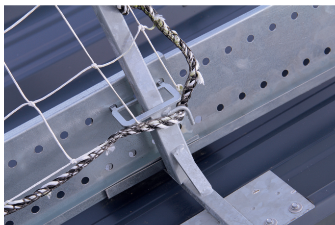
Plinthe perforée + porte plinthe installé sur toiture métallique
