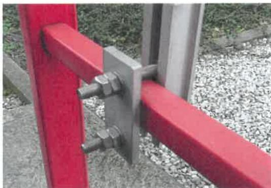
*Exemple de fixation au milieu d'un barreau*
