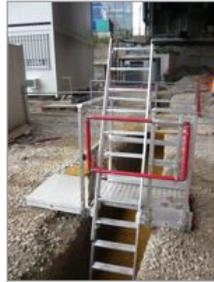
L'accès à des fouilles entraîne des situations complexes et des risques qui mettent en danger la sécurité des usagers. 2/3 des accidents de travail sont dans des fouilles de moins de 3 m de profondeur.
