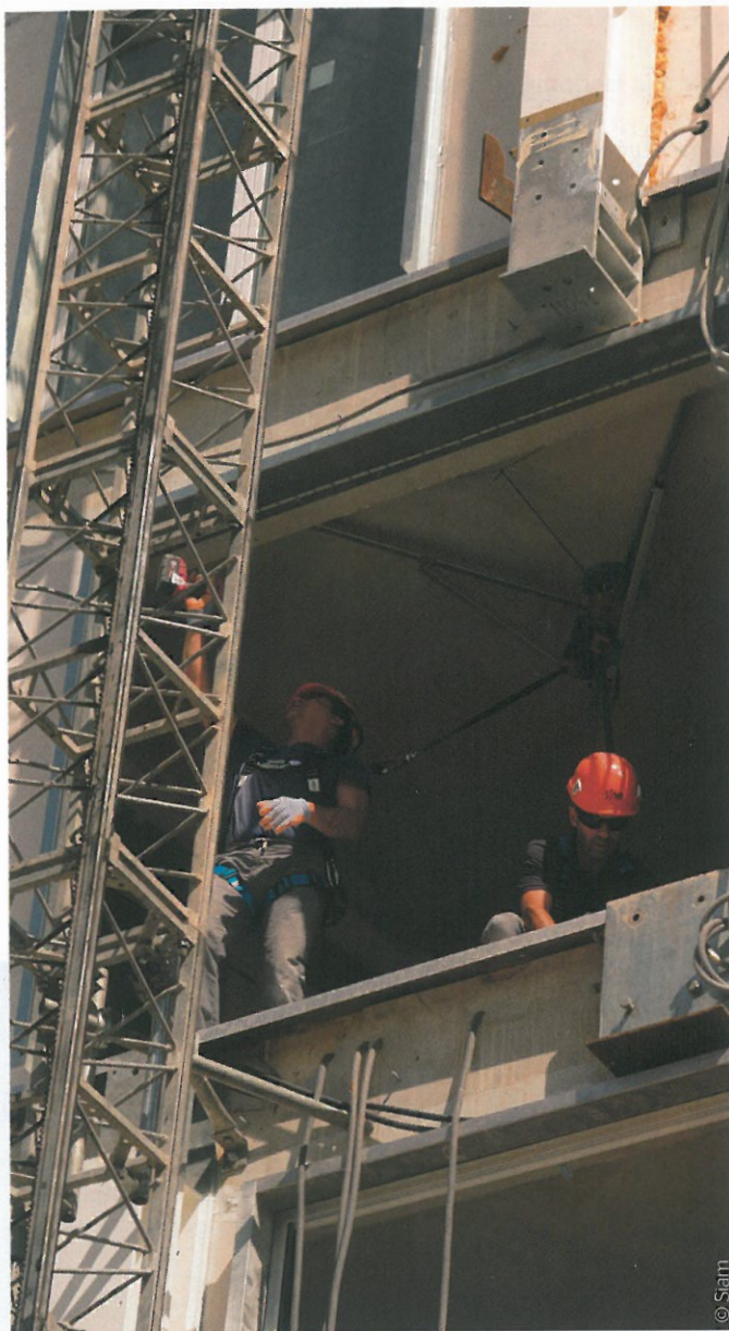
Poseurs équipés en Syam sur le chantier de l'Arbre Blanc.
